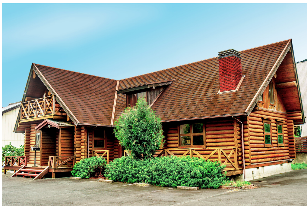
豊橋新本社：ログハウスをリノベーションした社屋
