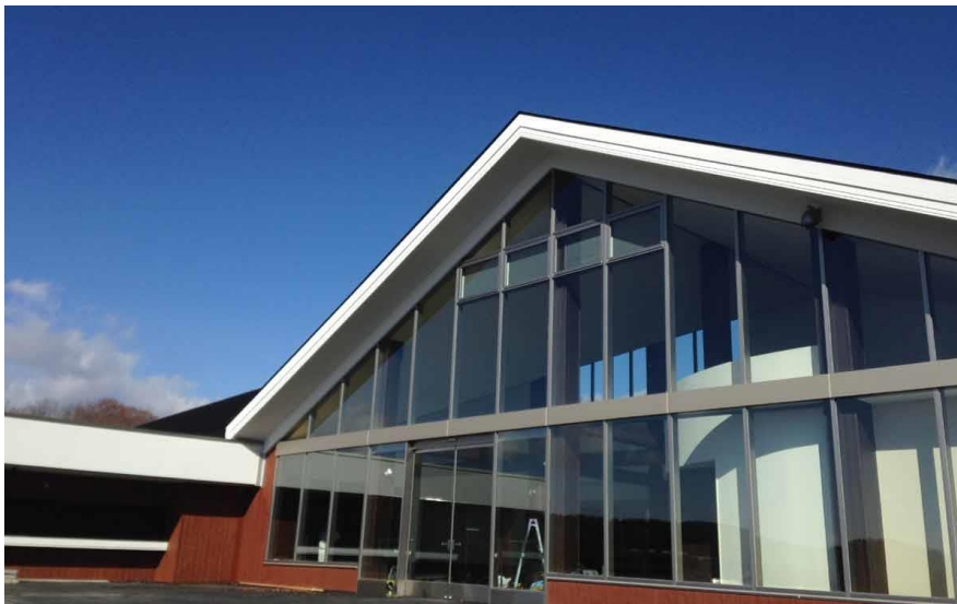
ガラス張りのおしゃれな外観は滑走前の気持ちを盛り上げる(11月10日撮影)
