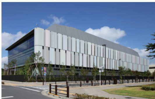
キヤノンMJグループ 西東京データセンター
