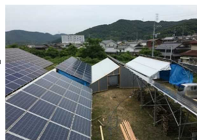
原木しいたけを育成するソーラーシェアリングの事例 (出典) 工藤宗介「太陽光パネル下でしいたけを取穫、遮光ネットで発電量アップ」『メガソーラービジネス』 2017年12月5日
