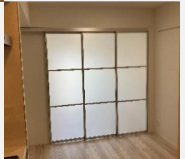
▲閉めても外の明かりが部屋に届く 可動式間仕切りドア
