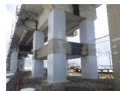
新幹線高架橋柱の耐震補強
