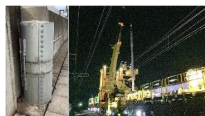
新幹線電柱の耐震補強
