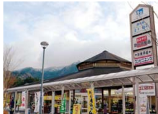
道の駅 いが(伊賀市)
