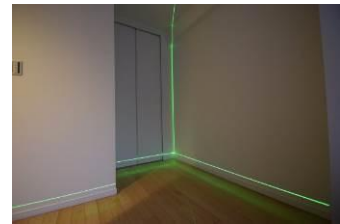
壁・床の水平垂直調査の様子
