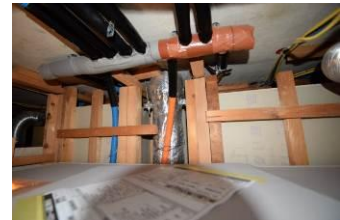
浴室上部の点検口内部の様子
