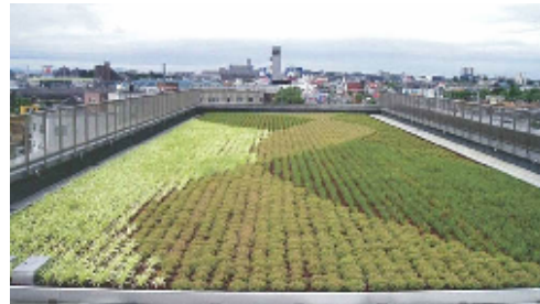
屋上緑化（施工例）
