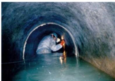
図-1 作業員による点検イメージ\*4
