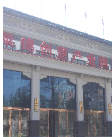
北京営業所の入る建物外観
