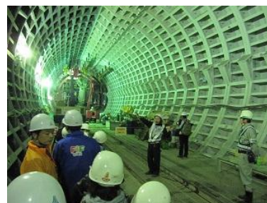
シールドトンネルの工事現場
