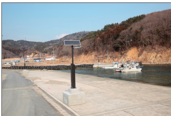
【写真説明：石巻市鮫ノ浦漁港に設置されたソーラー式LED照明（左：点灯前、右：点灯時）
