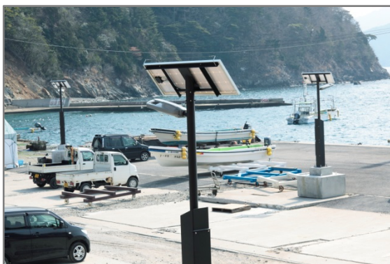
【写真説明：石巻市前網漁港に設置されたソーラー式LED照明（左：点灯前、右：点灯時）
