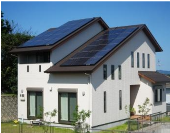
※福岡県福岡市 邸 （太陽電池容量 : 3.67kW）
