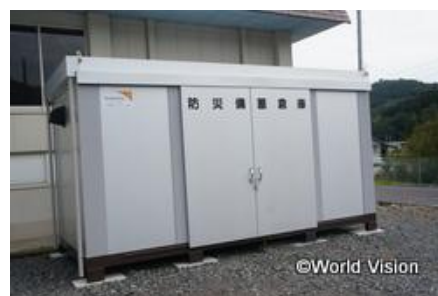
小学校に設置された防災倉庫
