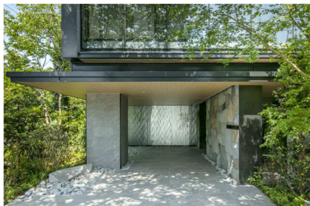
【居住者を迎える石壁のエントランス】
