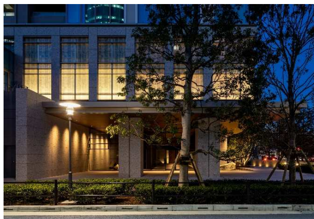
【周辺地域の街並みとの調和に配慮した景観】
