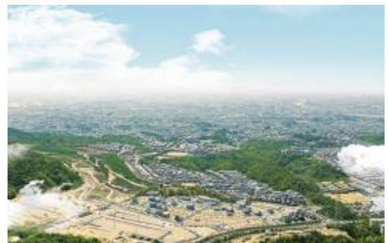
※上空より山手台を見下ろす景色 (2013 年 5 月撮影)
