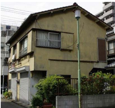
↑建物2階右手に出入りできない「高所トマソン」
