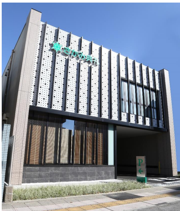
やすらぎホール熊谷 外観
