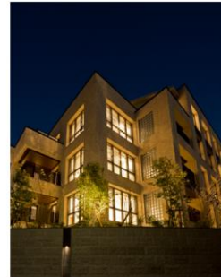
ローレルコート覚王山御船町 (2015年竣工)
