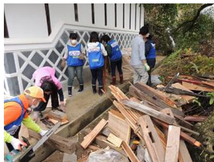
瓦礫を撤去する 従業員ボランティア
