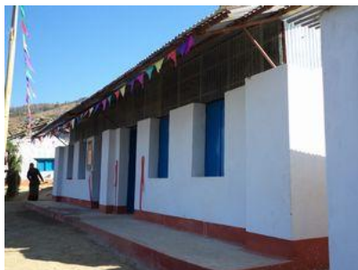
《支援を受けて建設された小学校》
