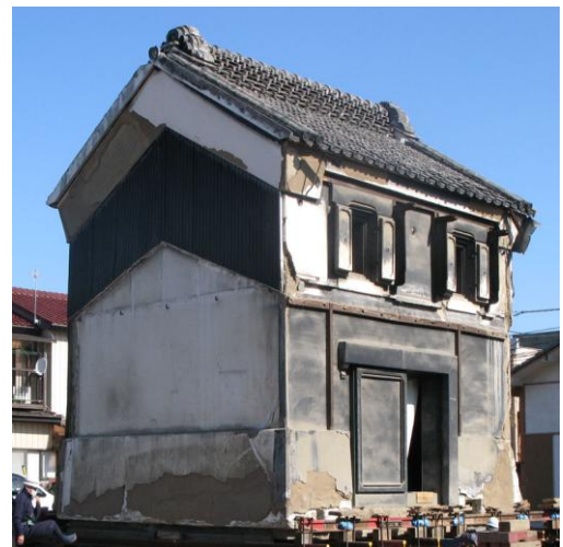
曳家工事をいう蔵
