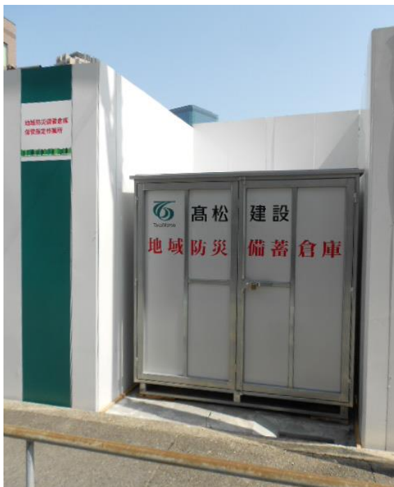
地域防災備蓄倉庫 設置風景
