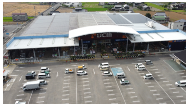
DCM周桑店の太陽光発電設備
