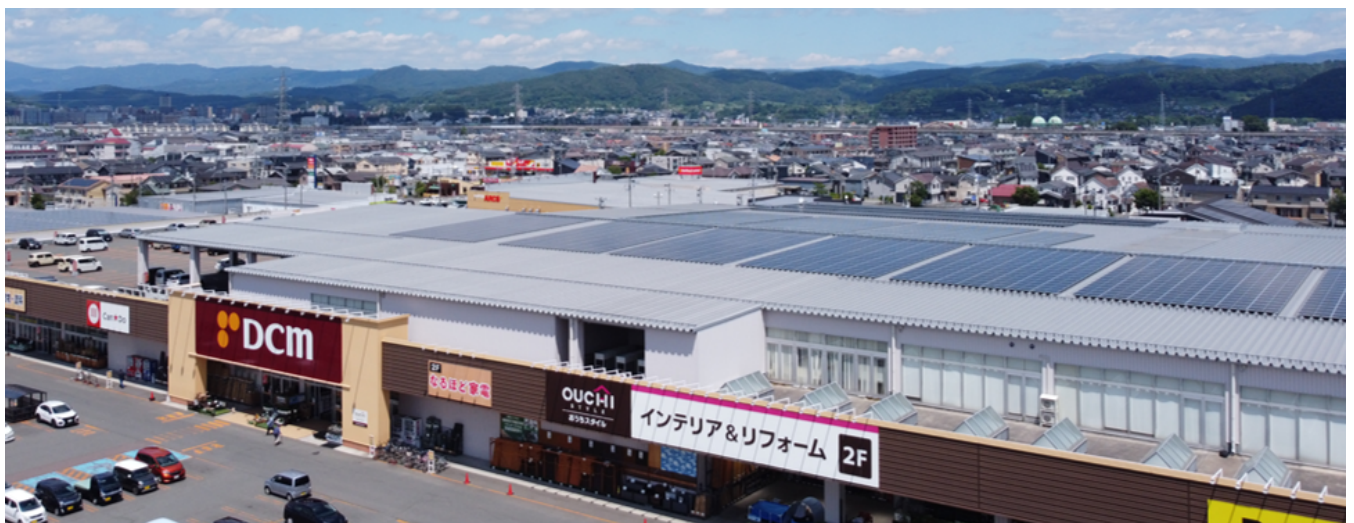
DCM盛南店の太陽光発電設備
