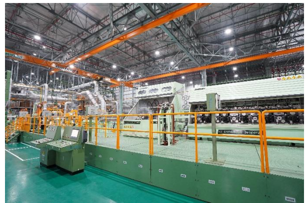
(新工場の圧延*設備)
