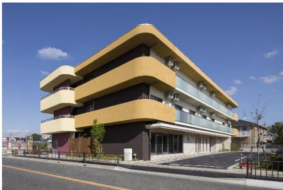
エニシエ川西加茂 外観写真
