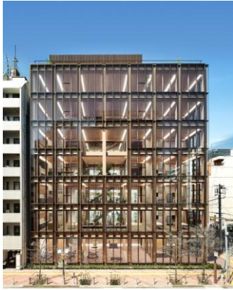
ジューテック本社ビル 鹿島建設株式会社／株式会社ジューテック／ 住友林業株式会社 建築・空間分野
