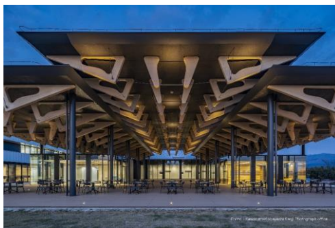
東海大学阿蘇くまもと臨空キャンパス食品加工教育実習棟 株式会社石本建築事務所／東海大学／三井住友建設株式会社／山佐木材株式会社 建築・空間分野
