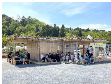
ウッドデザイン賞 2024 受賞 可変型 CLT ユニット ハイブリッド建築構造システム (東北大学大学院工学研究科 前田研究室ほか)
