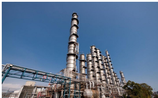
水島工場 GPI プラント外観
