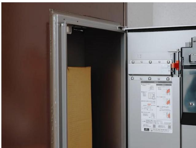
各居住部のそばに必ず設置してあるメーターボックスの扉部分をくりぬき、**メーターボックス内部の奥行きを活用**することで宅配ボックスを設置します。
