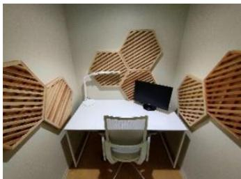
本製品の試作品を設置した個室で、パネルの有無による「音環境」と「見た目の印象」の違いについて調査したところ、同試作によって“音響調整機能と意匠性向上の両効果が実感できる”との回答が得られました。この実証実験は「ウッドデザイン賞 2023」を受賞しています。
