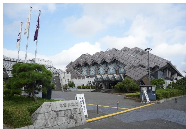
東京武道館（足立区・綾瀬）
