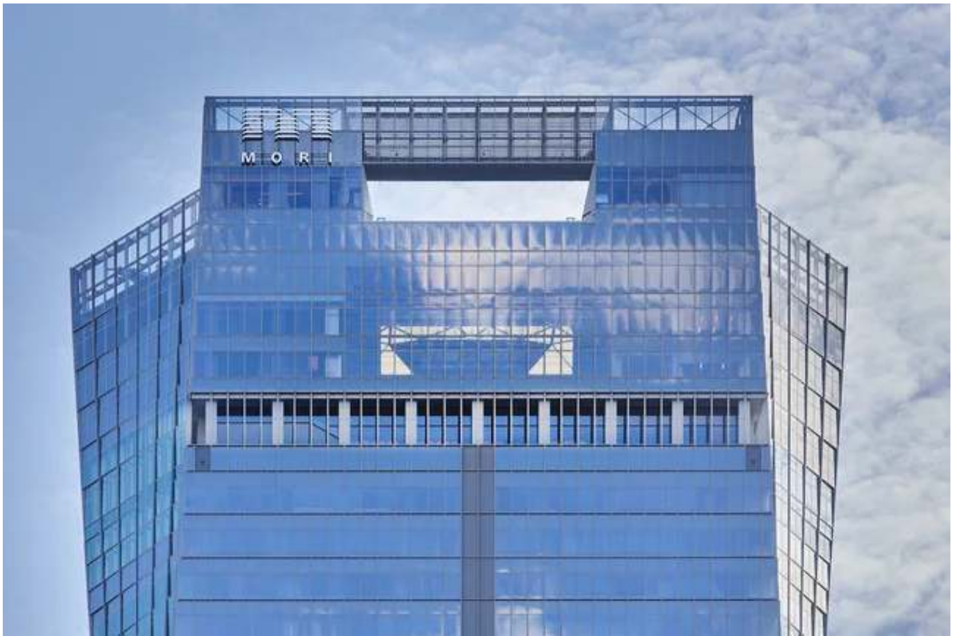
虎ノ門ヒルズ ステーションタワー 上層階
