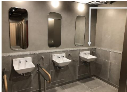
▲トイレ洗面台への敷石の活用
