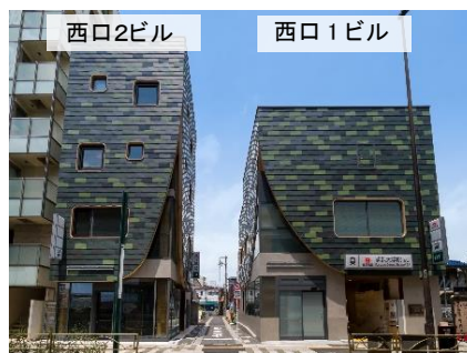
▲木造4階建ての駒沢大学駅西口2ビル(左)
