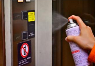
エレベーターへの施工イメージ
