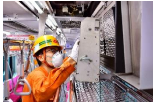
コーティング済みフィルター取付作業
