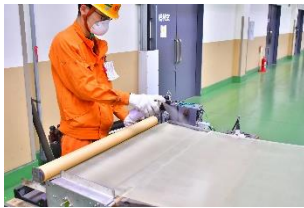
空調フィルターコーティング作業
