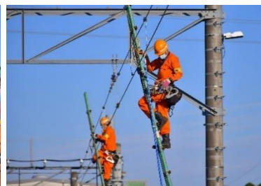
垂れ下がった架線を修復
