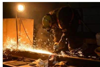
(夜間作業の様子)
