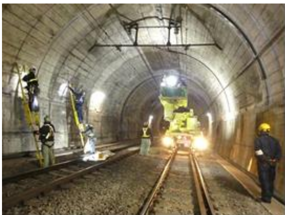
(トンネル打音検査)
