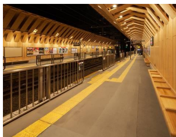
(センサー付固定式ホーム柵)
