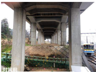
▲耐震補強工事
