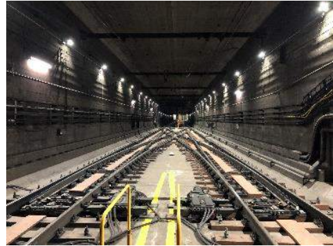
▲折り返し運転施設(用賀～二子玉川間)
