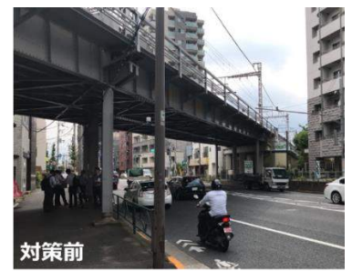
▲ロッキング橋脚を有する橋りょう
