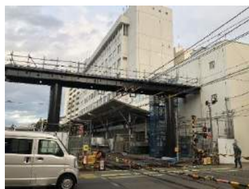
▲工事中の奥沢駅
