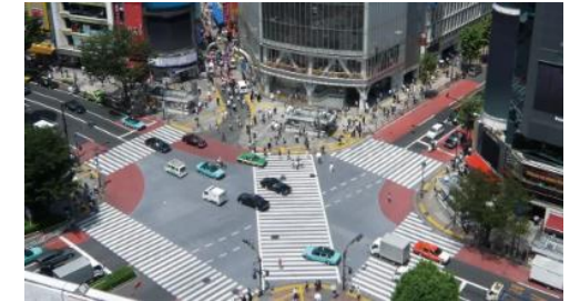
路面の温度上昇を抑制する舗装
