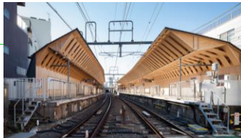
リニューアル後の戸越銀座駅 多摩地域生育・生産の「多摩産材」を活用
