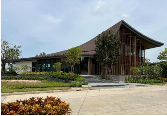
▲共用棟(クラブハウス)
