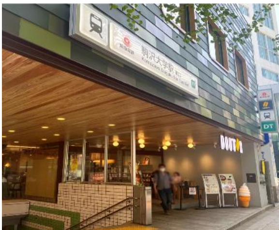
▲駒沢大学駅東口の木材天井
