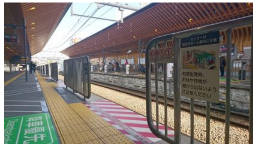
▲池上線市旗の台駅のセンサー付固定式ホーム柵
