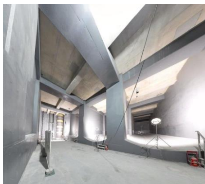
▲雨水貯留施設の内部
