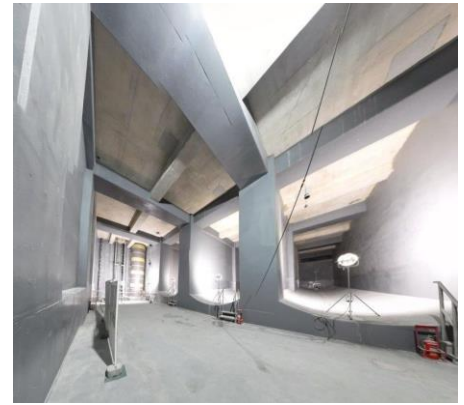
▲雨水貯留施設の内部
