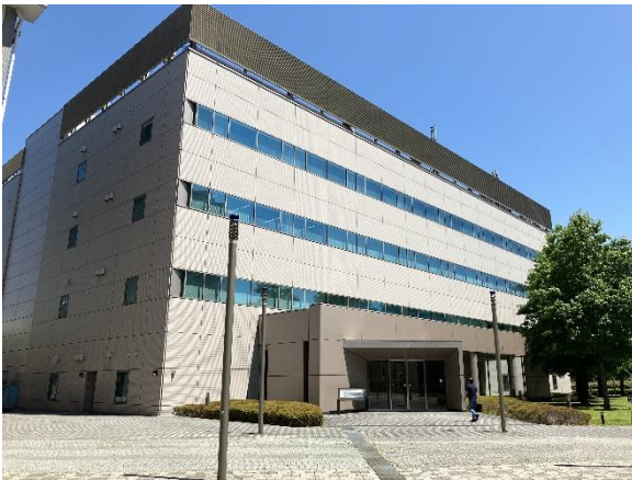
横浜ビジネスパーク テクニカルセンター 外観
