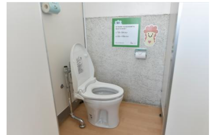
改修したトイレ(洋式化)
