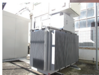
厚木第一工場 高効率アモルファス 変圧器への更新
