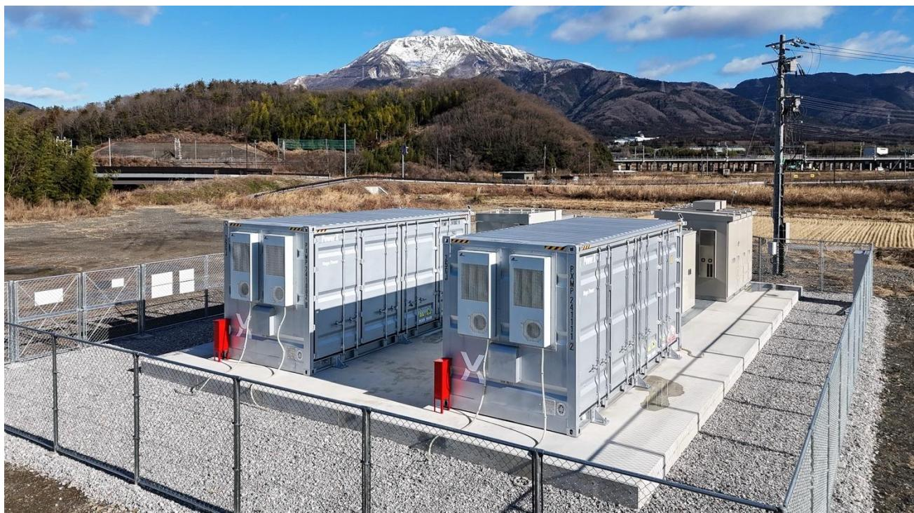
本システムを採用した「米原長岡蓄電所」は、関西エリアの電力系統に接続し、電力が余剰となる時間帯に充電を行い、不足する時間帯に放電することで、電力需給バランスの安定化を図ります。これにより、再生可能エネルギーのさらなる導入拡大への貢献が期待されます。
