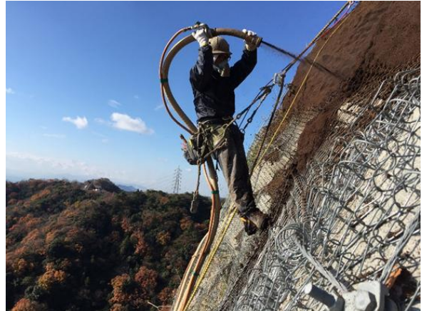
作業員による法面吹付施工
