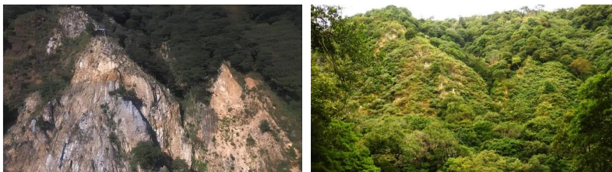
法面への植生基材吹付前（左）、在来種子を用いた植生基材吹付後（施工 4 年半後）
