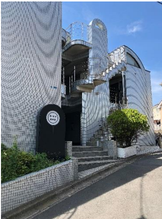
【コットンハウス外観】
